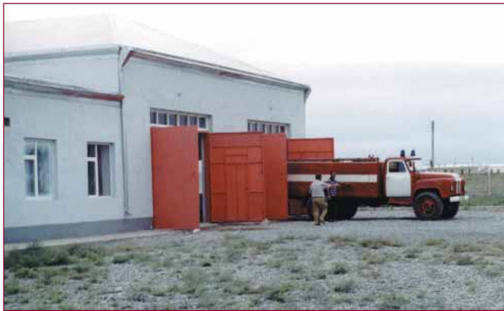
Biləsuvar rayonunda məcburi köçkünlər üçün tikilmiş infrastruktur obyektləri (məktəb binası, yanğınsöndürmə məntəqəsi, elektrik yarımstansiyası)
